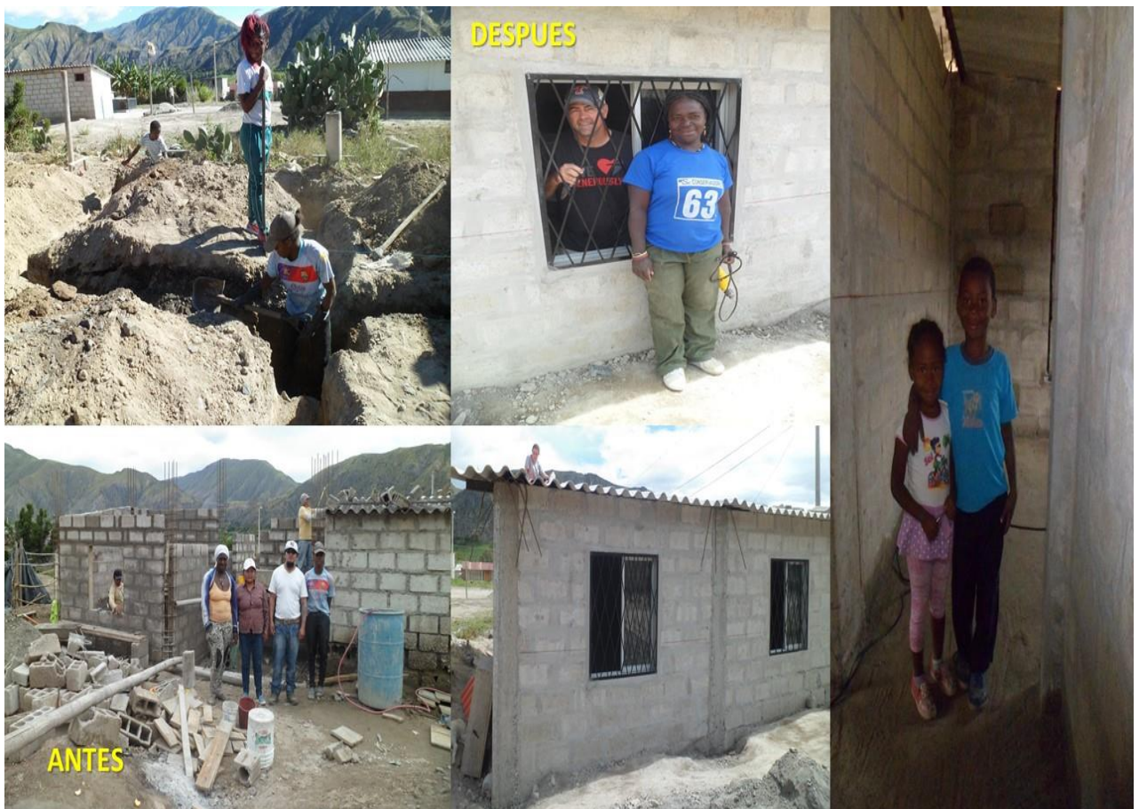
b) Construcción de Casa PATRICIA PALACIOS .
